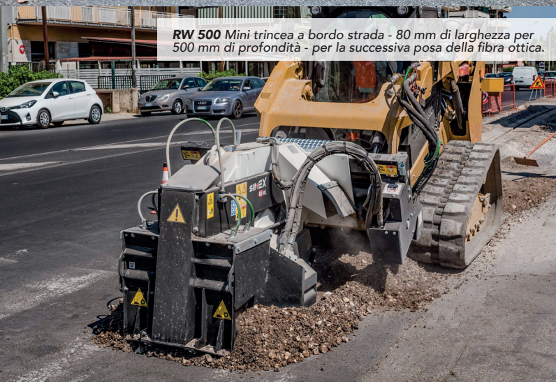
RW 500 Scavo con ruota da 120 mm di larghezza per la successiva posa della fibra ottica.
